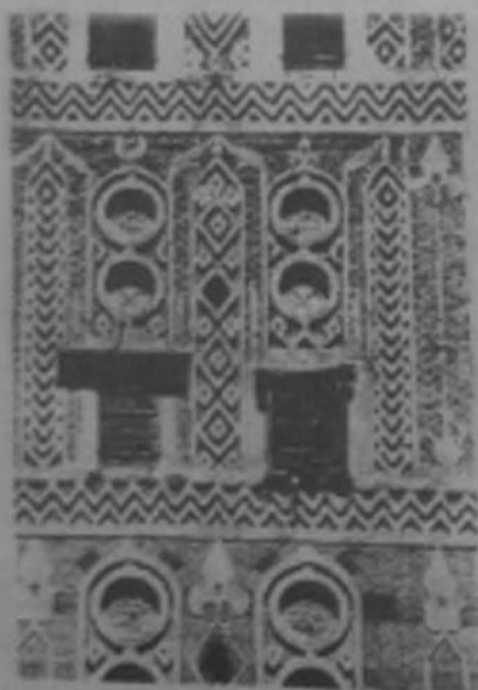
شكل (٦٤-٢) تستخدم مادة البناء كمادة إنشائية ومادة لتشكيل العناصر في آن واحد
