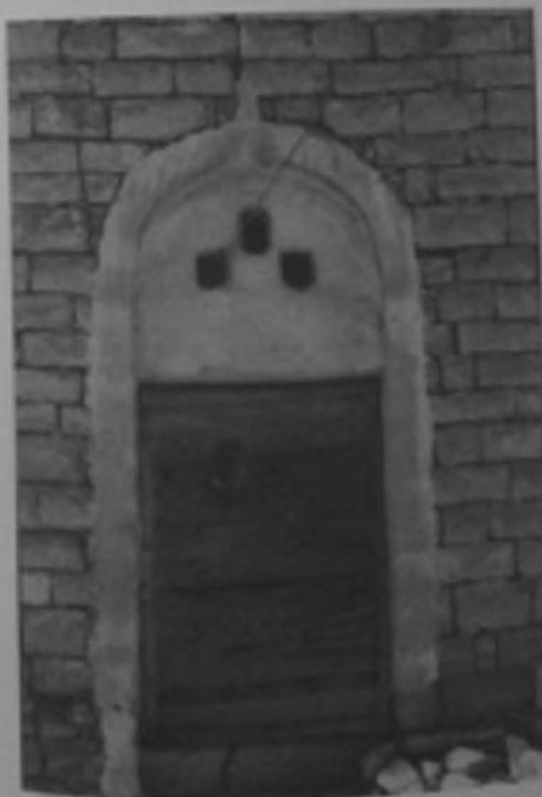
شكل (٦٨-٢) تغيير أنماط الأبواب فمنها التي تأتي على مستوى الحائط دون إطار وهذا بالنسبة للمناطق التي بنيت مبانيتها بالطين أو الباجور
