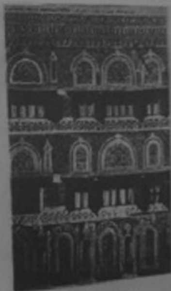
شكل (٧٨-٢) نماذج الأقاريز عملت على فصل الطوابق ولتحديد الأدوار وتظهر أحجام الأقاريز بشكل أكبر كلما تعددت الأدوار «الكنه» تعمل على صد الشمس والمطر
