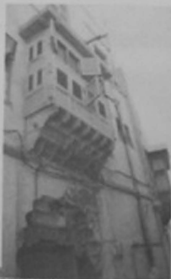
شكل (٧٥-٢) أنماط الشبايك وأساليها المختلفة تبعاً للمناطق والتي تعمل على الرؤية من الداخل إلى الخارج وتحجب الرؤية كما تساعد في تحريك الهواء الداخلي
